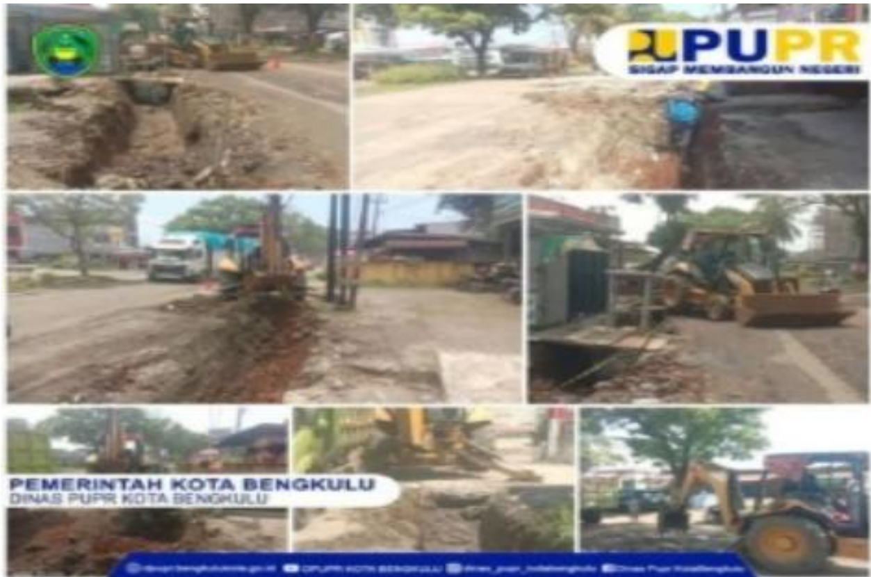
Gambar 2 Pengerokan siring dan penambalan jalan (Sumber : Website Pupr dan Website Kominfo Kota Bengkulu)
