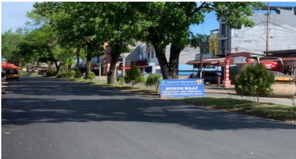
Gambar 3 Separuh jalan hibrida sudah mulus (Sumber : Dokumentasi Pribadi)
