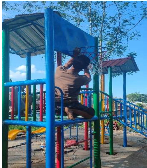
Gambar 3. Pemasangan dan pengujian wahana bermain rintang bola
